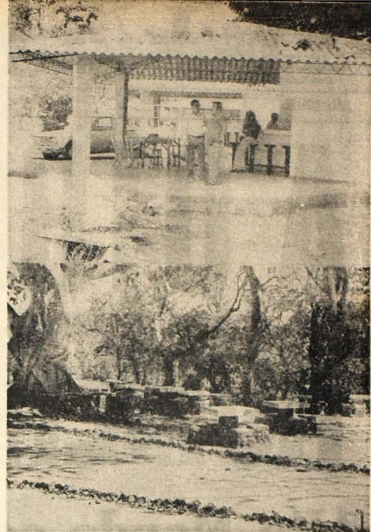
UN MILLON. Un millón 707 mil 740 colones invierte el ISTU en la construcción del "Turicentro La Toma" de Quezaltepeque. Arriba, merenderos que están a disposición del turista. Abajo, atractiva área de "picnics", que servirá de descanso para los visitantes del parque.
