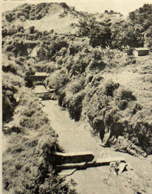
DAÑOS DEL RÍO LAS CAÑAS. La corrientada del río Las Cañas, al costado norte de la pista principal del aeropuerto de Ilopango, está causando daños. Los muros de contención fueron arrastrados y la vía férrea que pasa por ese lugar ha quedado en el aire. (Foto de Peña Zambrano).
