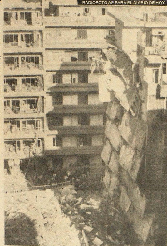
DESTROZOS DE BOMBA.—Beirut, agosto 13. Bomberos y trabajadores de rescate remueven los escombros del edificio destruido por una explosión, donde murieron decenas de personas. Derecha, parte de otro edificio dañado.
