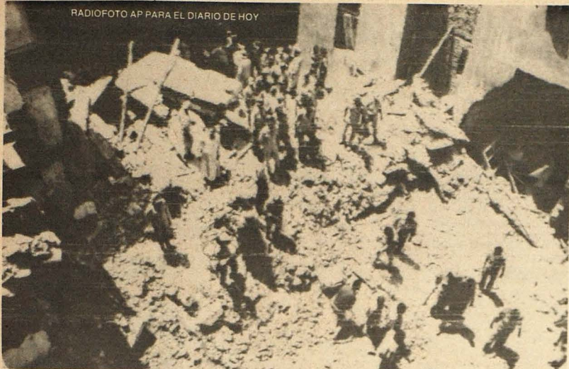
MUEREN 40 PERSONAS. — El Cairo, Egipto, julio 24. Los trabajadores de rescate remueven los escombros del edificio que se derrumbó hoy y causó la muerte de más de cuarenta personas.
