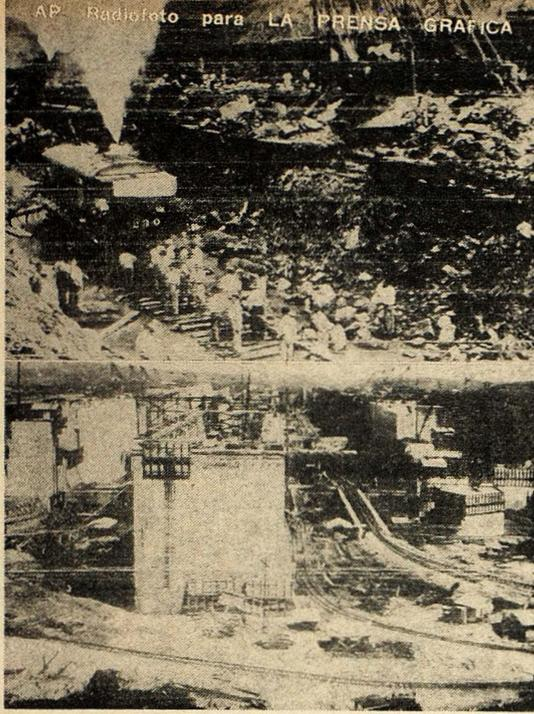
CONSTRUCCION. Washington, septiembre 5. (AP). Estas dos excavadoras norteamericanas a vapor completaron en 1913 los trabajos de excavación en Culebra Cut, para la construcción del Canal de Panamá (arriba). Enormes estructuras de cemento constituyen las esclusas superiores del Lago Gatún. (Fotografía tomada en 1911 (abajo).
