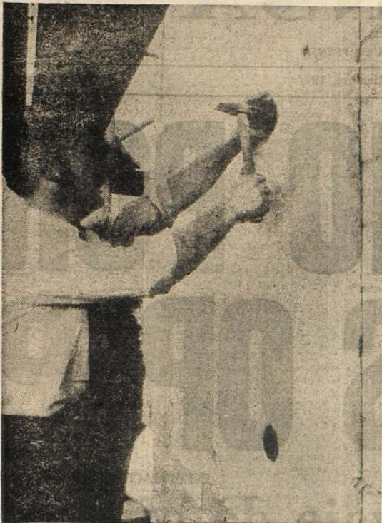
**CAPAS TERMICAS.** Bonn, septiembre 3 (INP). Estas capas de fibra textil, mineral de aislamiento térmico, impiden el calentamiento de las murallas durante el verano. En el invierno conservan por más tiempo la temperatura ambiental de los muros interiores calefaccionados.
