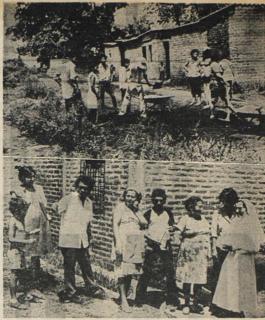
VIVIENDA MINIMA. En su fase final se hallan los trabajos de construcción de 500 viviendas mínimas en la ciudad de Sonsonate. El proyecto denominado "Sensunapán", lo desarrolló la Fundación Pro-Vivienda Mínima. Arriba, familia trabajando en la construcción de su propia casa. Abajo, religiosa de la Fundación, da indicaciones.
