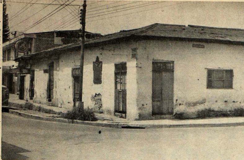
RELIQUIA HISTORICA. Casa ubicada frente a la Administración de Rentas, en donde falleció el prócer Manuel José Arce. Actualmente hay un salón de bebidas, lo que constituye una falta de respeto para un lugar que debiera ser monumento histórico. (Foto de Hidalgo-Zeledón).
