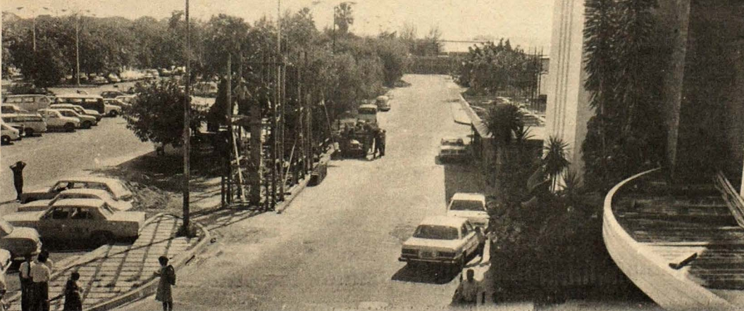
REMEDIACIÓN. Se encuentran avanzados los trabajos de remodelación del Aeropuerto de Ilopango, en el sector llamado "Salida de Pasajeros". En ese lugar será construido un plafón
