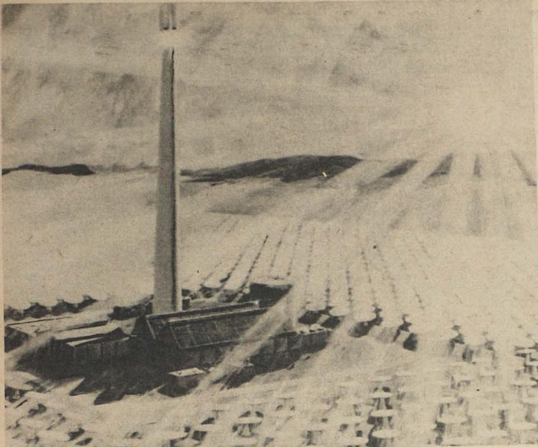
APROVECHAMIENTO DE ENERGIA SOLAR. Los Angeles, agosto 28. Diseño de la empresa McDonnell Douglas de una central heliostática capaz de desarrollar una fuerza de 10.000 kilovatios, a partir de la energía solar. Grandes espejos concentran los rayos del sol para convertir el agua en vapor, que moverá un generador eléctrico capaz de producir energía suficiente para una comunidad de unas 7.000 personas.
