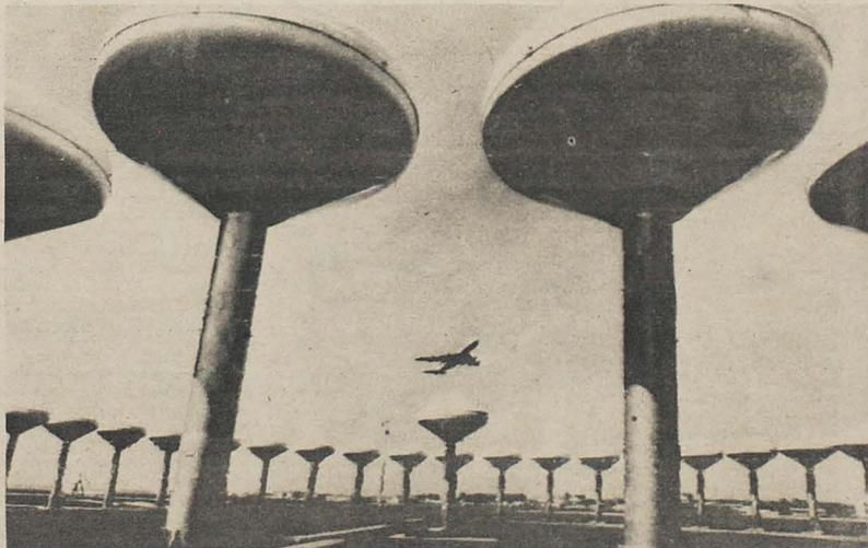
ORIGINALES ANTENAS. Frankfurt, mayo 27. Cuarenta antenas que forman parte del alcance de radio direccional en la principal base aérea norteamericana del Rin, en Frankfurt, Alemania Occidental. Estos "hongos" transmiten señales de radio para ayudar a los pilotos en navegación.
