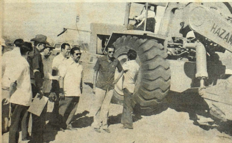
EN EL AEROPUERTO CUSCATLAN. El Presidente Molina estuvo ayer en el sitio donde se iniciaron los trabajos para el aeropuerto Cuzcatlán, en el sector de Comalapa. El mandatario, frente a un "tornapouli" acompañado del subsecretario de Obras Públicas, Arquitecto Vásquez, del Embajador de Japón, señor Hayashi y de los funcionarios de CEPA, Ings. Luis Andreu, Reyes, y Hernández. Estuvieron como invitados el general Romero y el comandante de la FAS coronel Regalado. (Foto de Peñate Zambrano).
