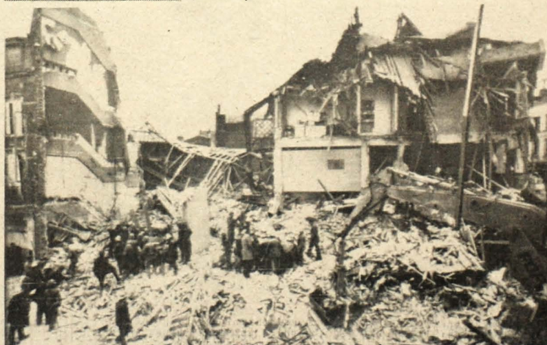
EDIFICIOS DESTRUIDOS POR EXPLOSION. San Quintín, Francia, noviembre 27. Bomberos y soldados hurgan entre los escombros de uno de los edificios destruidos esta madrugada por una explosión de gas en San Quintín, población del norte de Francia. La Policía informó de muertos y heridos.
