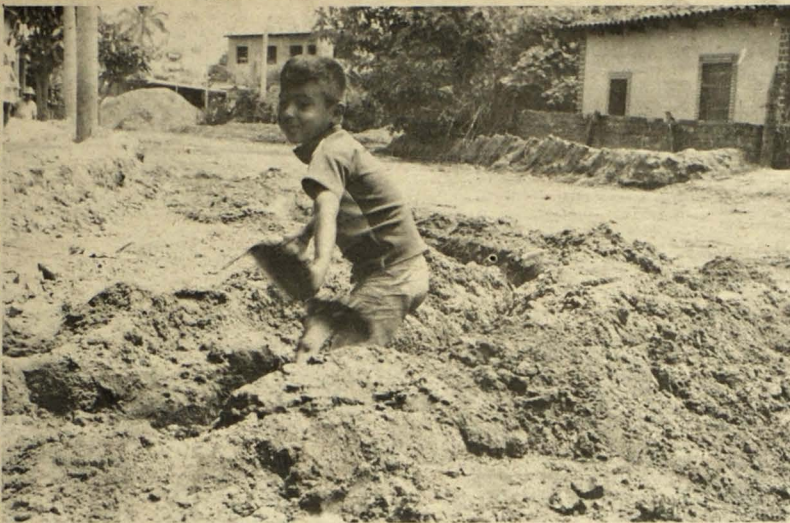
ARENA CAUSA DAÑO EN COLONIA. Los vecinos de la colonia San Antonio Buena Vista, jurisdicción de Soyapango, están preocupados por las lluvias que arrastran arena de los trabajos que realiza DUA en ese sector. Las calles están intransitables al acumularse la arena con basura y lodo. Los habitantes piden la inmediata intervención de Obras Públicas. (Foto de Pedro Rodríguez).
